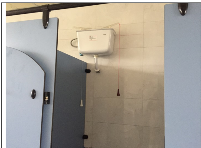
廁所用二段式沖水系統
